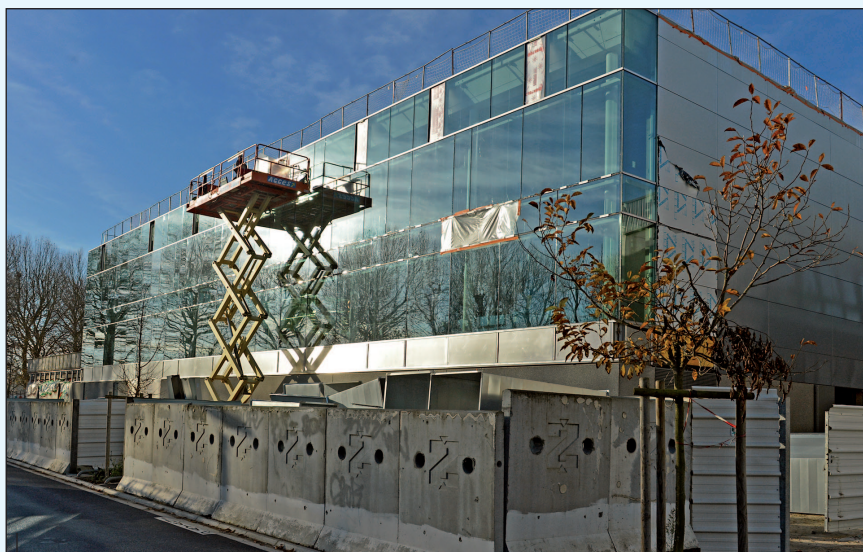
2012 début du chantier du Stade Nautique.
